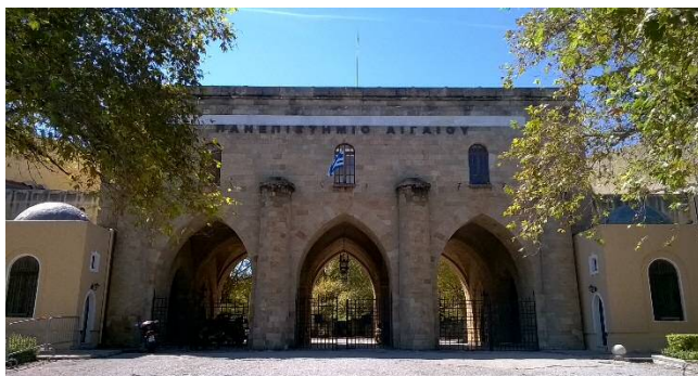
(Haupteingang der Universität. Sep. 2015)
